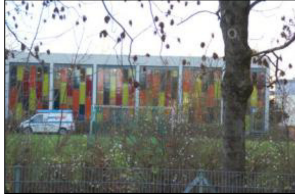
Abb. 66: Die Turnhalle der Grundschule vom Dr. Behrens Weg aus gesehen
